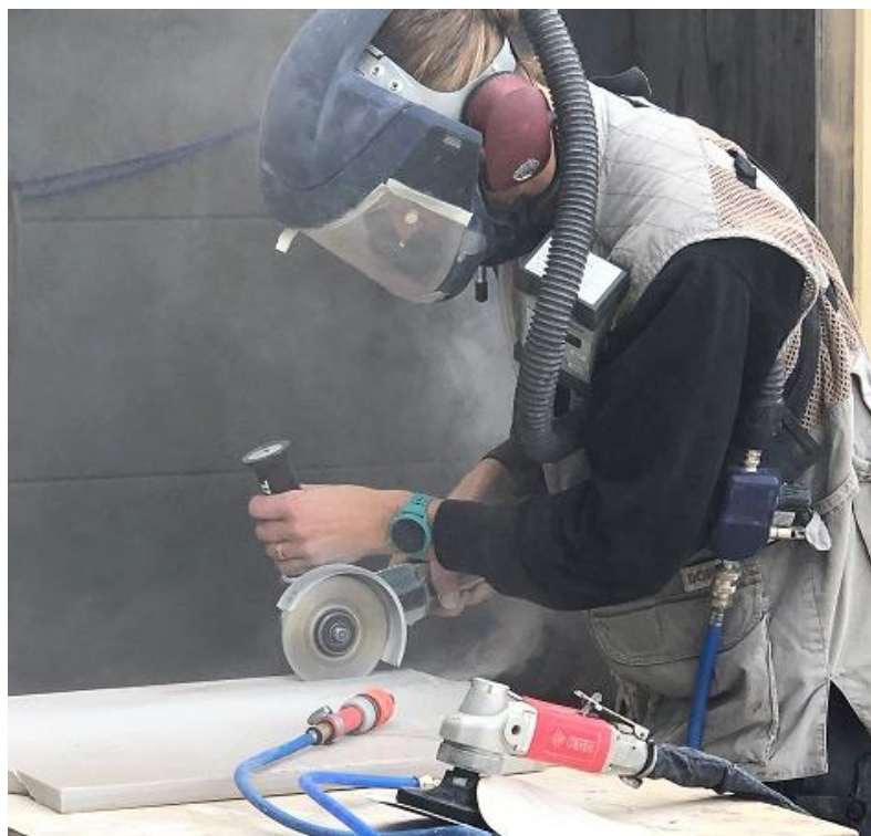
Bild 1. Användning av fläktassisterat andningsskydd vid torrkapning utomhus
