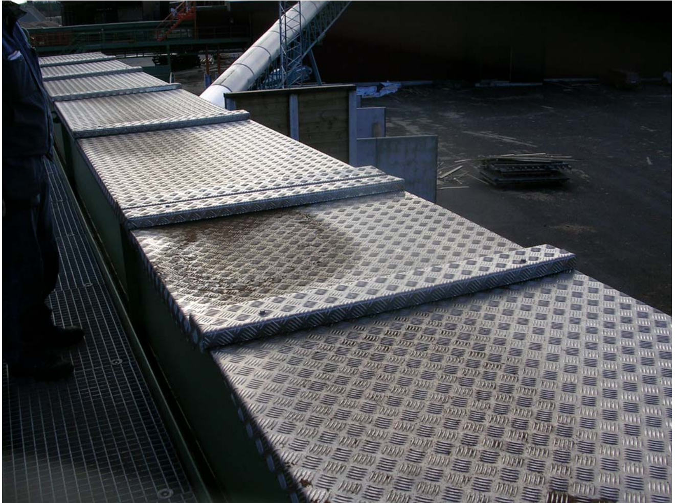
J 4. Barkhanteringen: Durkplan lågt placerat i förhållande till greetingsplan. Om någon går upp på durkplanet finns risk för fall till marknivå.
