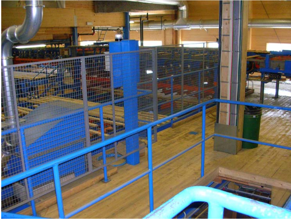
Exempel på fallskydd (tvådelat räcke) och skyddsanordning (staket).
