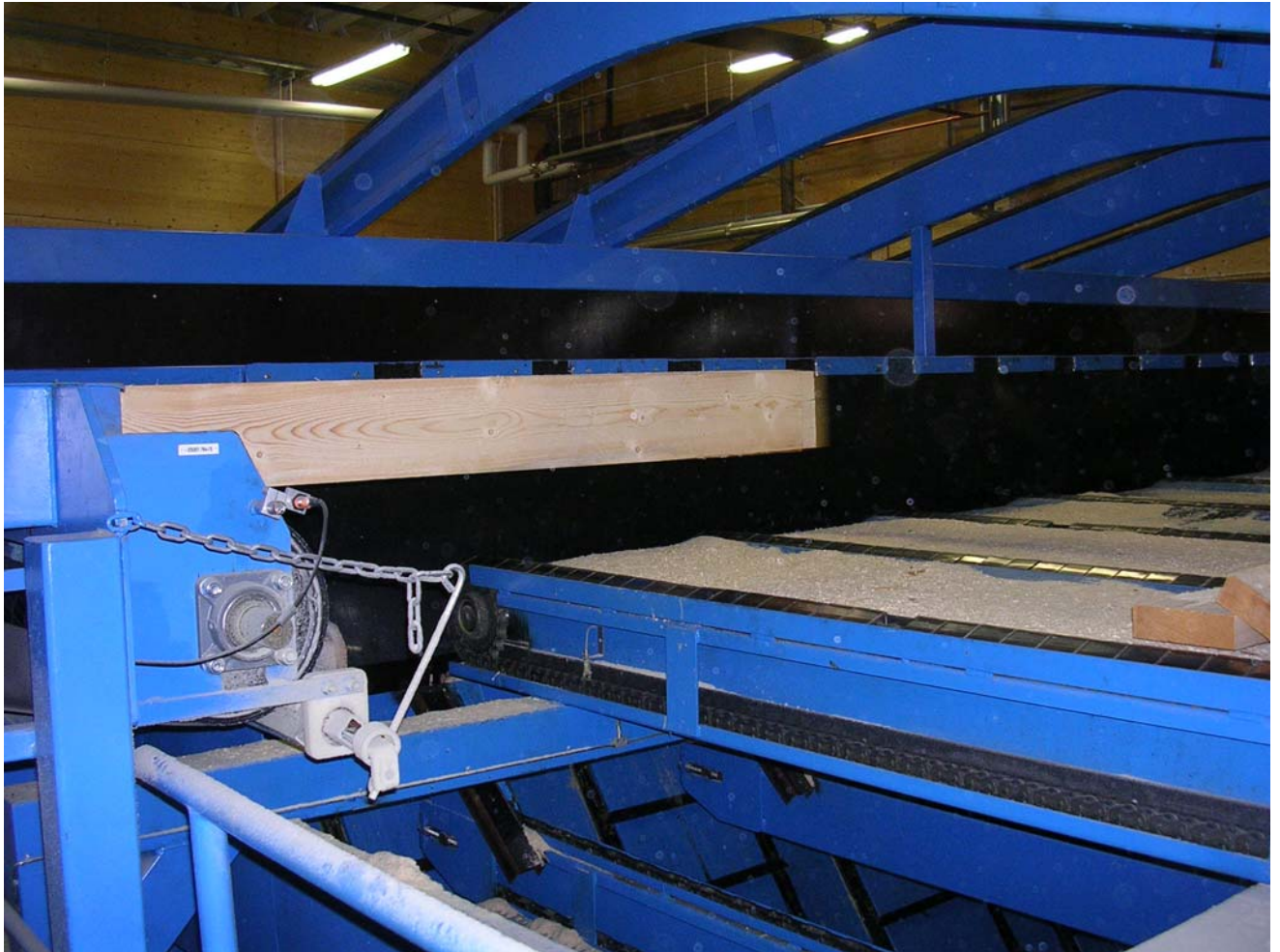
A 6. Inmatning av plankor till råsorteringen: Tvåledigt räcke, 1,1 m höjd, med gallerdurk på insidan. Lätt att ta sig in till riskområdet där stockar med hög hastighet matas från såghuset.
