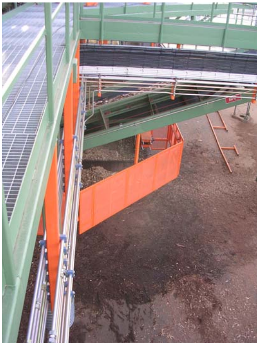
A 15 Skydd vid städskrapa: lätt att krypa under och ta sig in i riskområdet trots att galler har monterats.
