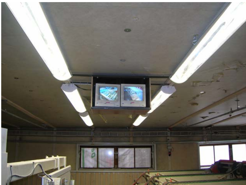
Synergonomi; dålig möjlighet till avläsning på bildskärm på grund av placering och omgivande reflexer.
