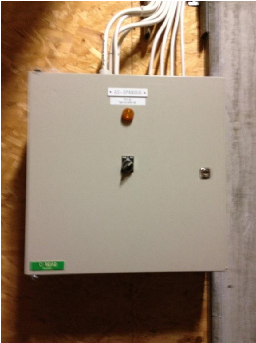
Bild 1. Styrskåp till spånsugsanläggning (processventilation). När vred ställs i läge manuellt kan spånsugen köras separat.
