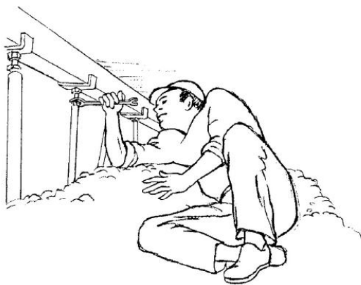
Figur 3 Arbete i kryputrymme medför mycket besvärliga arbetsställningar.
