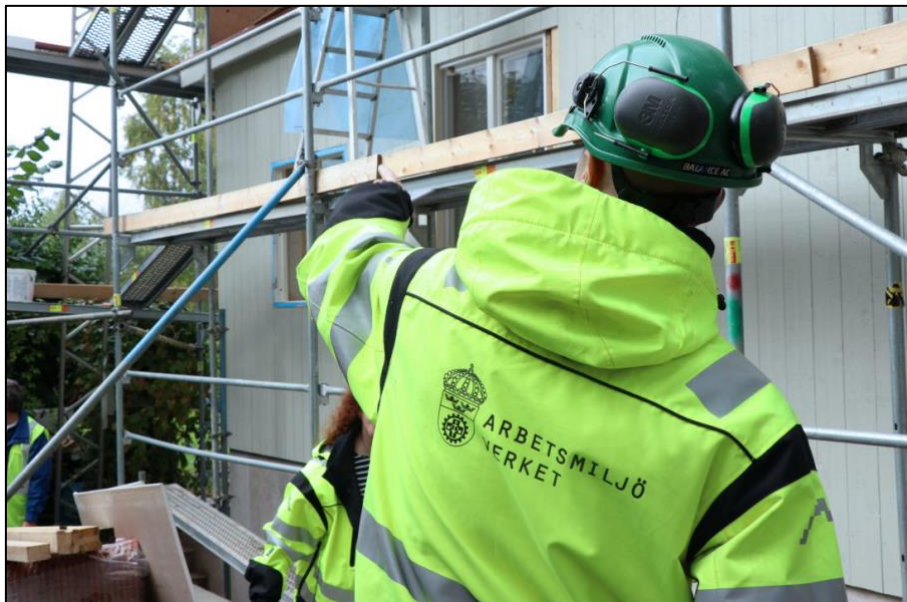
Bild 3. Myndighetsgemensam kontroll av en byggarbetsplats.
